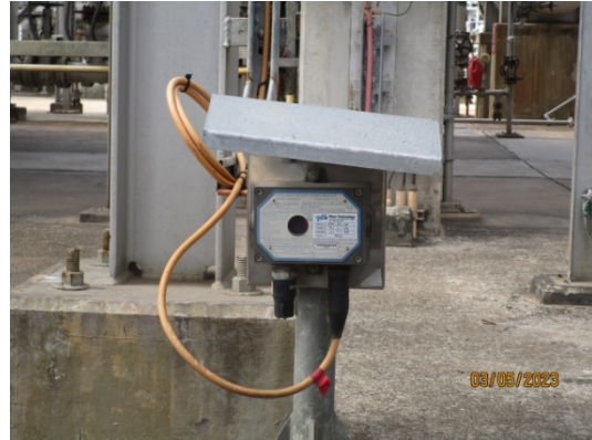
รูปที่ 54 Gas Detector
