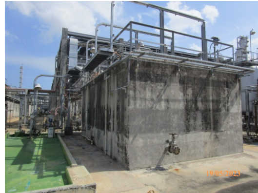
รูปที่ 18 หน่วยบำบัดน้ำเสียสำเร็จรูป (Sanitary Package) จากอาคารสำนักงาน (2930-ME 168)
