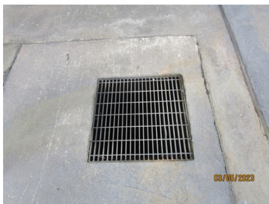
รูปที่ 15 ระบบระบายน้ำที่อาจปนเปื้อนน้ำมัน (Potential Oil Contaminated Water Sewer : POC)
