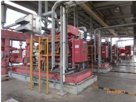
รูปที่ 59 ปืนสูบน้ำดับเพลิง
