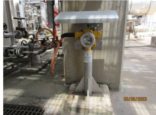
รูปที่ 66 ระบบตรวจจับก๊าซที่มีความเป็นพิษ (Toxic Gas Detector)
