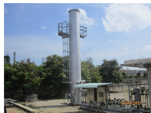
รูปที่ 34 หน่วยกำจัดไอไฮโดรคาร์บอน ในระบบบำบัดน้ำเสีย (Vapor Disposal Unit)
