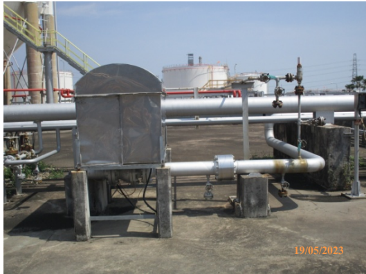
รูปที่ 92 Remote Shut-off-Valve (ปลายทาง)
