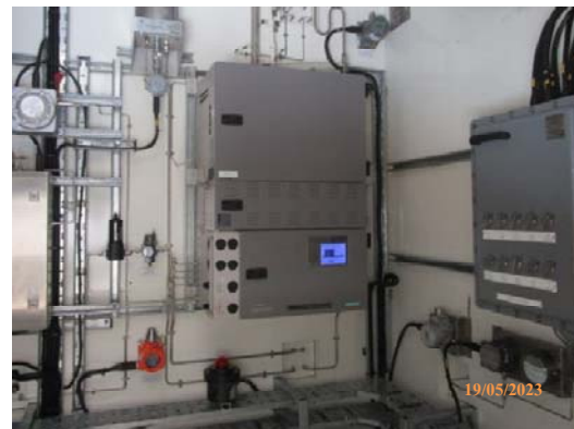
รูปที่ 10 เครื่องมือตรวจวัด THC Analyzer ที่ปล่อยระบายอากาศของ VRU
