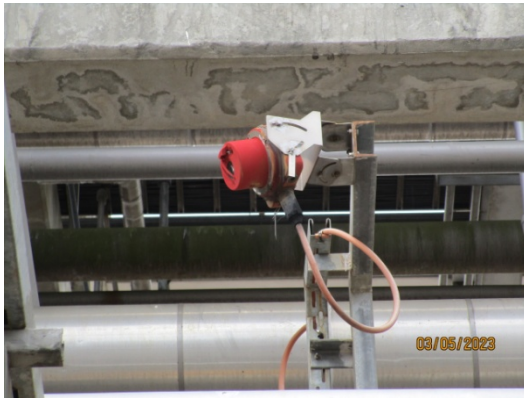
รูปที่ 53 Flame Detector
