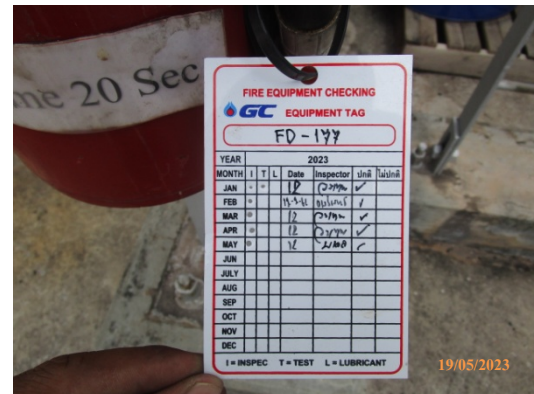
รูปที่ 68 การตรวจสอบอุปกรณ์ดับเพลิง (Tag Inspect)
