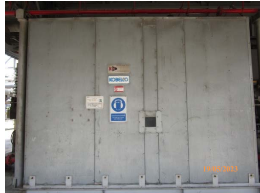
รูปที่ 48 การปิดครอบเครื่องจักรที่มีเสียงดัง
