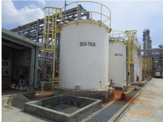
รูปที่ 35 หน่วยบำบัดปรอทในน้ำเสียจาก กระบวนการผลิต (น้ำจาก Desalter) (NEW ETP)
