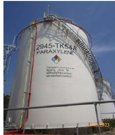
รูปที่ 8 ถังสำรองสารไฮโดรคาร์บอนทั่วไป เป็นชนิด CRN
