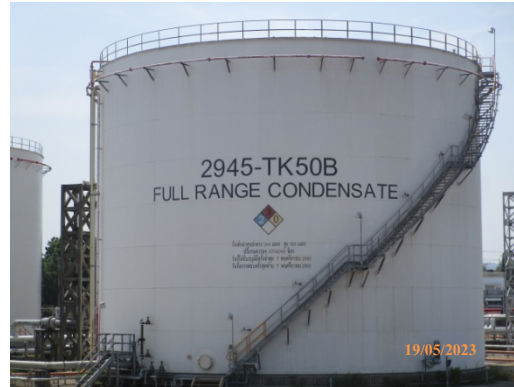
รูปที่ 6 ถังสำรองสารไฮโดรคาร์บอน ที่ระเหยง่ายเป็นชนิด IFRN
