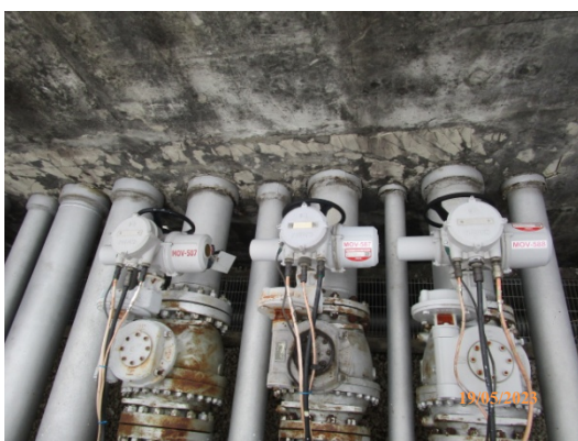
รูปที่ 90 วาล์วตัดแยกระบบ (Isolate Valve) ปลายทาง
