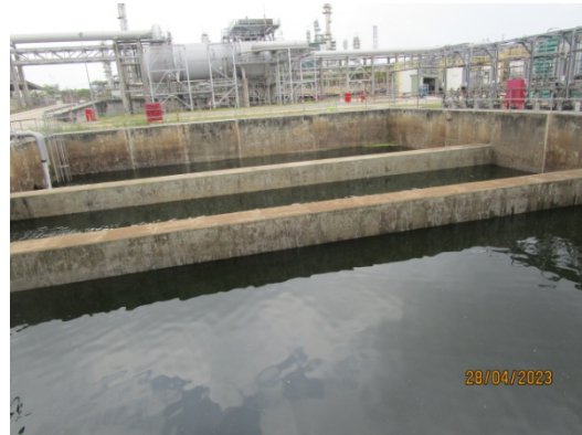
รูปที่ 30 Final Effluent Basin (2930-XC 20)
