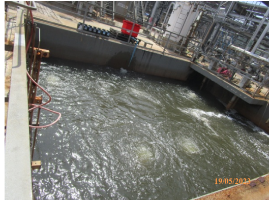
รูปที่ 20 บ่อปรับสภาพน้ำเสีย (2930-XC 12)
