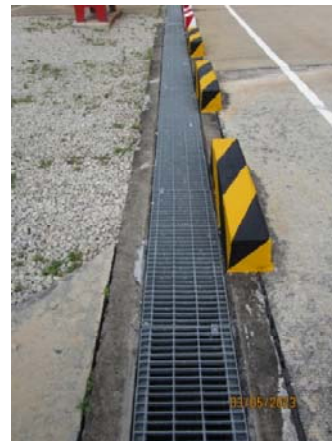
รูปที่ 14 ระบบรวบรวมน้ำไม่ปนเปื้อน (Clean Water Sewer : CWS)
