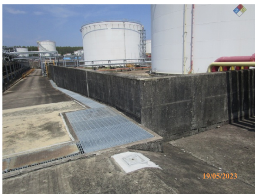
รูปที่ 72 กำแพง (Dike) ล้อมรอบถังเก็บวัตถุดิบและผลิตภัณฑ์
