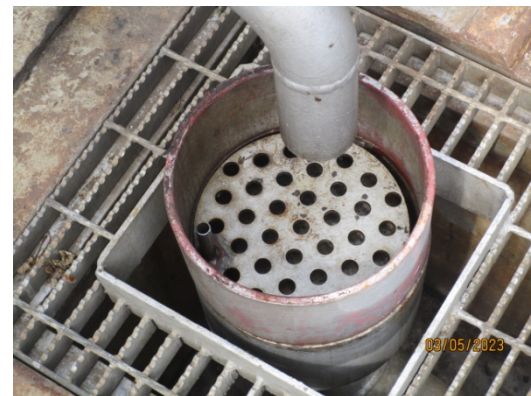
รูปที่ 16 ระบบระบายน้ำเสียจากกระบวนการผลิต ที่ปนเปื้อนน้ำมัน (Oil Water Sewer : OWS)
