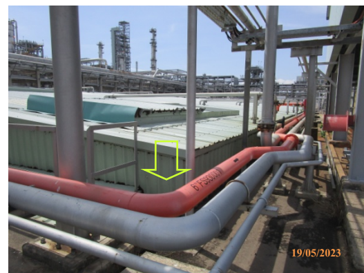
รูปที่ 32 ท่อรวบรวมไอไฮโดรคาร์บอนจาก Holding Basin ไปยัง Vapor Adsorber
