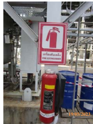
รูปที่ 60 ถังดับเพลิงแบบมือถือ
