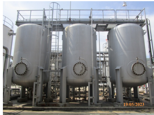
รูปที่ 28 Hg Adsorbent Filter สำหรับบำบัดน้ำเสีย ปนเปื้อนปรอทจากกระบวนการผลิต (น้ำจาก SWS)
