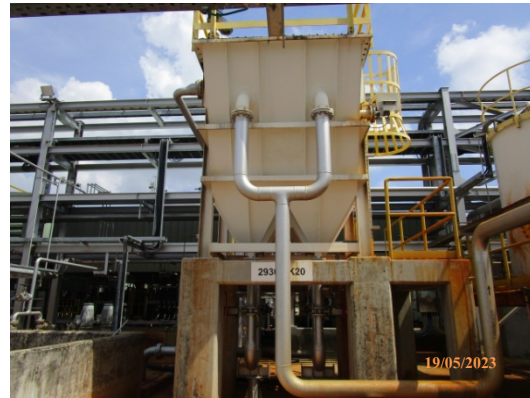
รูปที่ 24 หน่วยแยกน้ำมันออกจากน้ำ (CPI) (2930-TK20) ของ New ETP
