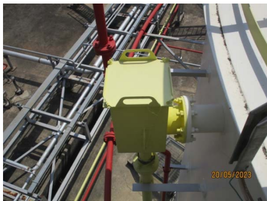
รูปที่ 82 Foam Chamber
