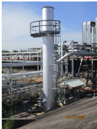
รูปที่ 13 ระบบกำจัดไอสารไฮโดรคาร์บอน จากการขนถ่ายสารไฮโดรคาร์บอนทางรถบรรทุก
