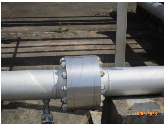
รูปที่ 88 Check Valve เพื่อป้องกันการไหลย้อนกลับ ออกจากถังรับที่ปลายทาง
