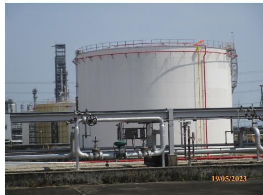
รูปที่ 89 วาล์วตัดแยกระบบ (Isolate Valve) ต้นทาง
